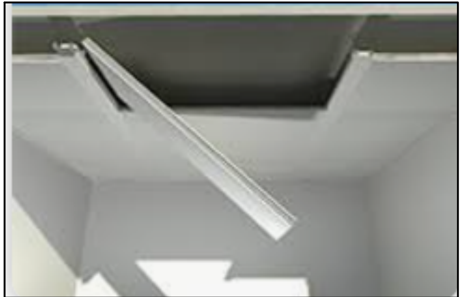
Podhled minerální deskový 1800/300/40 mm, desky odnímatelné pro přístup k zařízení TZB. Požární odolnost dle zprávy PBR - EI30/DP1.
